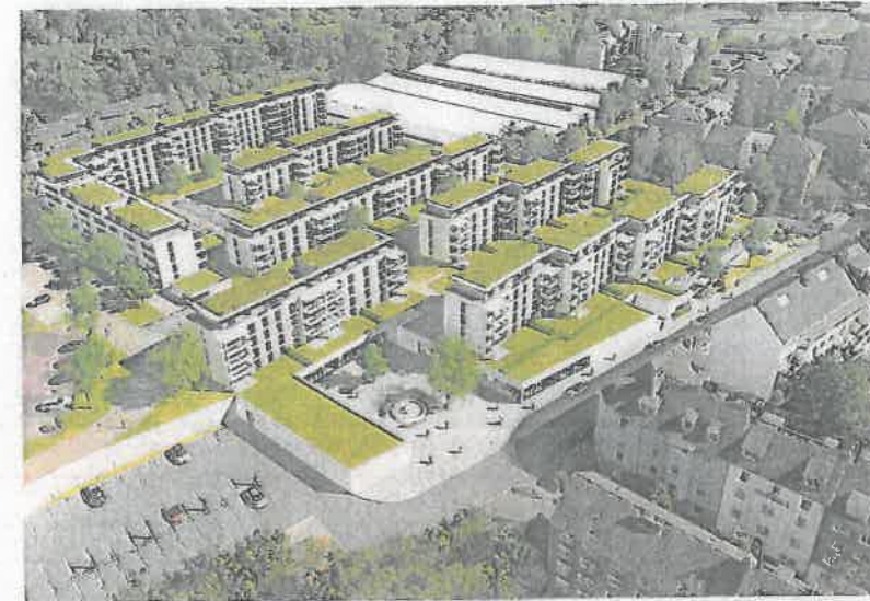
Die Arcadia Höfe in Rath mit mehr als 200 Wohnungen sollen 2022 fertiggestellt sein. ANIMATION: BRUNE IMMOBILIEN
